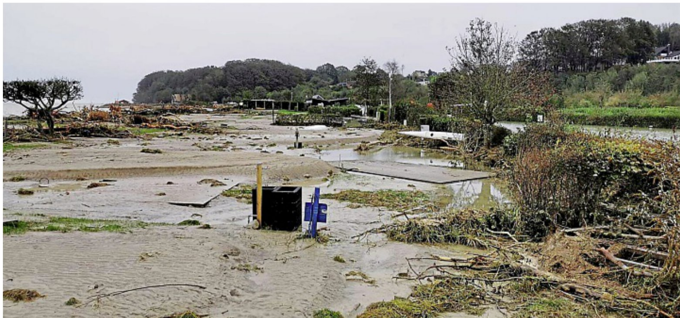
Der Campingplatz nach der Sturmflut: Sandmassen, Treibholz und weggespülte Zeltplätze.
